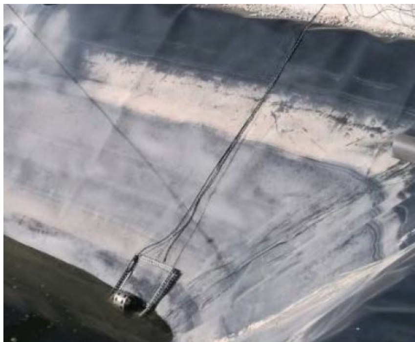
Figuur 6. Ballast- en druksensor.
